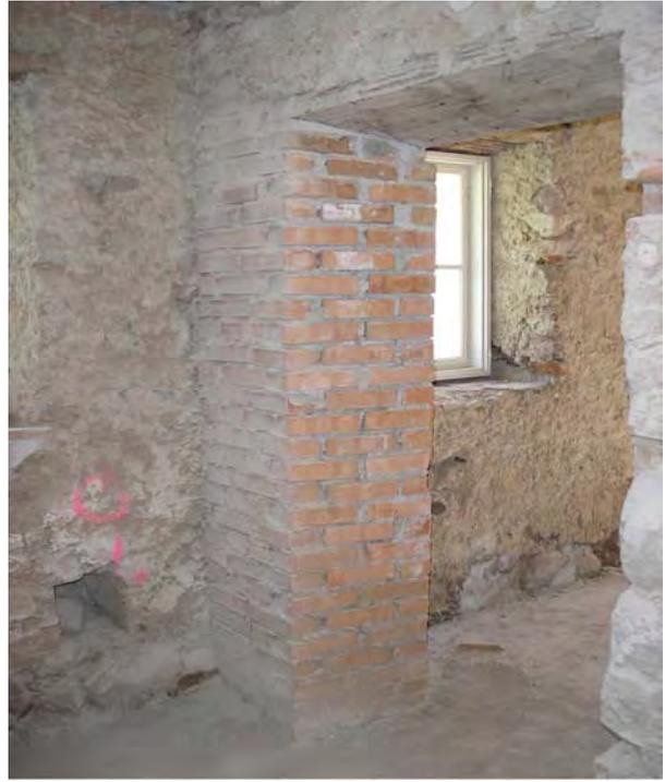
Im Mittelgang des EG wurde ein Mauerpfeiler aus Ziegeln mit Kalkmörtel neu aufgemauert.
